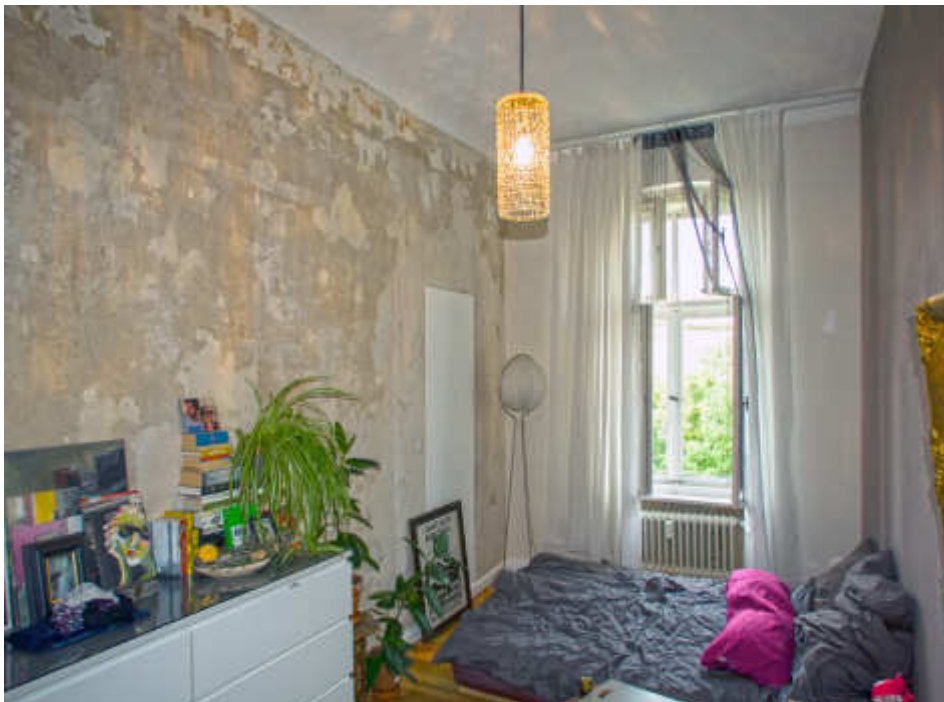
Wohnung Nr. XX, VH (Schlafen, unsaniert)
