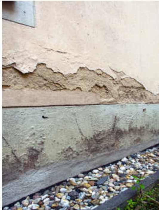
Sockelbereich der Fassade (nach Kellerabdichtung)
