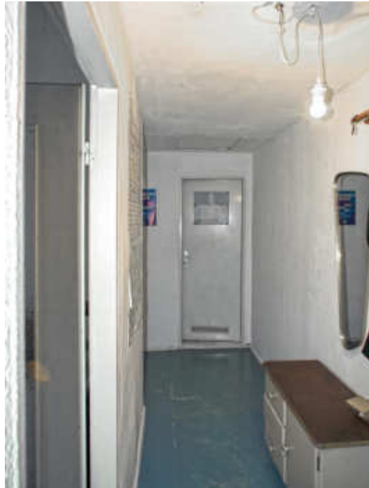
Wohnung Nr. XX, GG (Flur, unsaniert)
