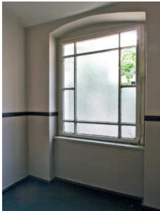
Treppenhaus im Gartengebäude
