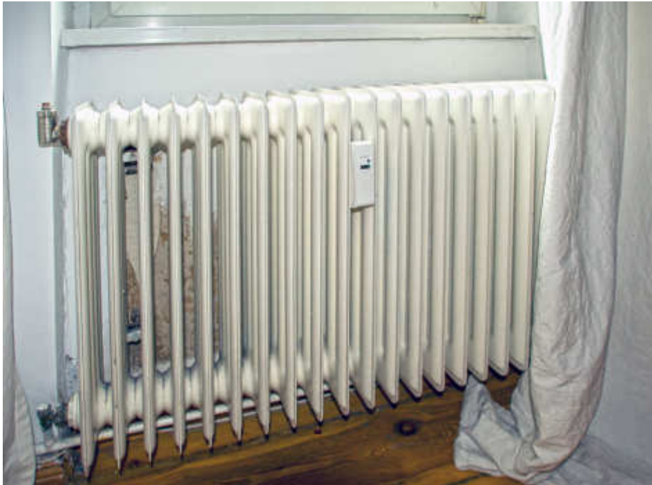
Wohnung Nr. XX, GG (Heizkörperdetail, unsaniert)
