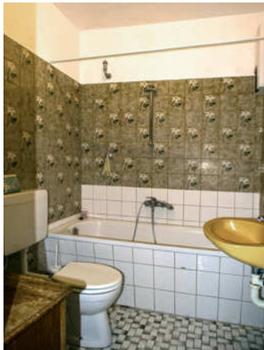
Wohnung Nr. XX, GG (Bad, unsaniert)
