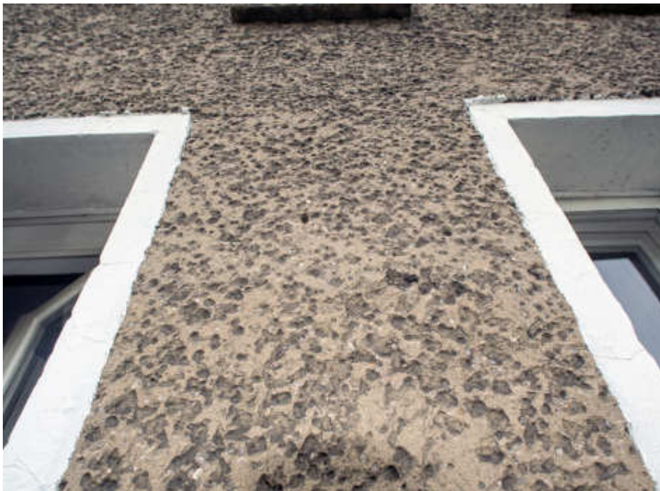
Fassadendetail (Dach, Straßenseite)
