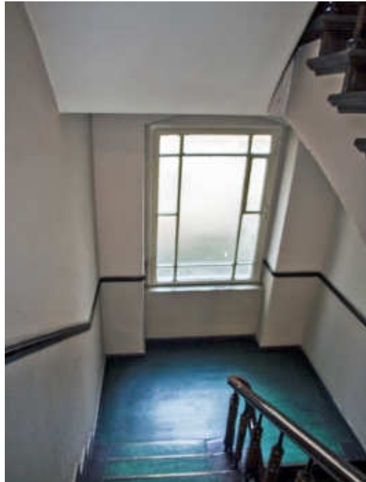
Treppenhaus im Gartengebäude
