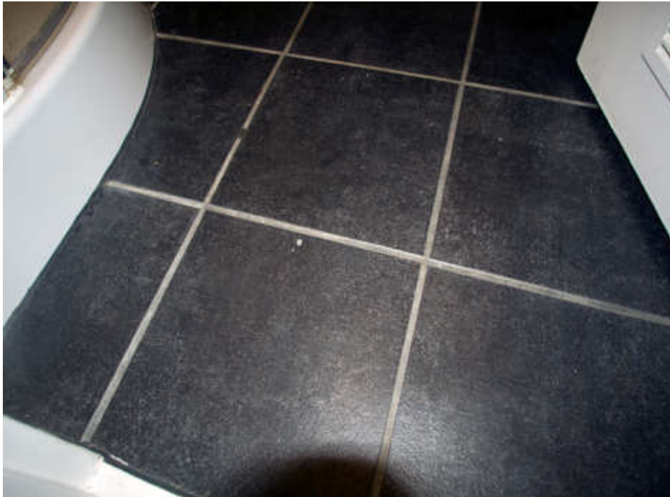
Wohnung Nr. XX, SF (Badfliesendetail, saniert)
